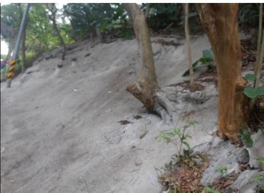
圖 4-14 140 高地水泥壁防土石流失
